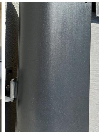
**that's it® PURE SURFACE PROTECT** est un revêtement dur extrêmement fin et élastique. Résistant aux intempéries et facile à nettoyer, **that's it® PURE SURFACE PROTECT** crée une surface non poreuse avec un effet anti-adhésion et protège ainsi complètement la surface revêtue pendant 5 à 7 ans.
